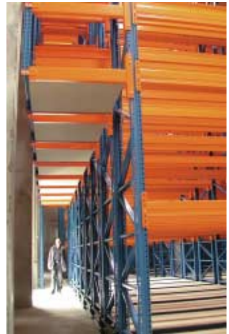
3: Fluchtwegüberbauung am Ende der Verschieberegalanlage
