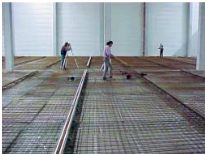
1: Maßprotokollierung der verlegten Lauf- und Führungsschienen
